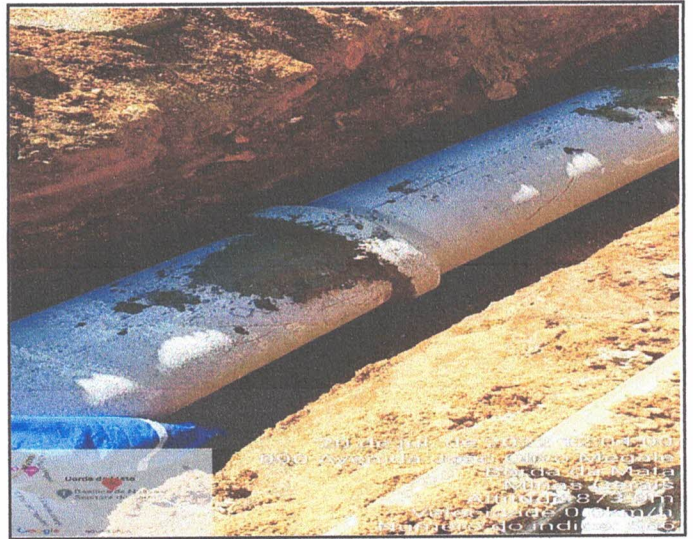
ESCAVAÇÃO DE VALAS / ASSENTAMENTO TUBOS
