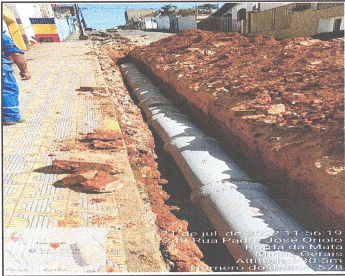
ESCAVAÇÃO DE VALAS / ASSENTAMENTO TUBOS
